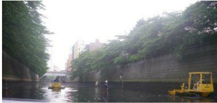
写真 5 河床整正の様子
